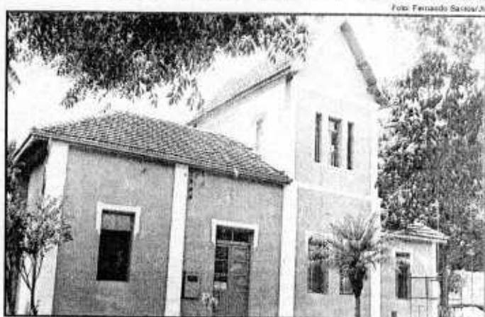
Memorial terá como sede o prédio da antiga Estação Ferroviária
