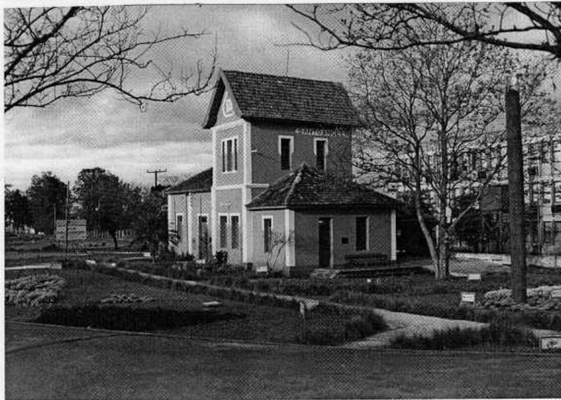
Prédio em 1996. Memorial Coluna Prestes. Ao fundo caixa d'água e ao lado direito em primeiro plano a obra Coluna Invicta de Mauricio Bentes.
