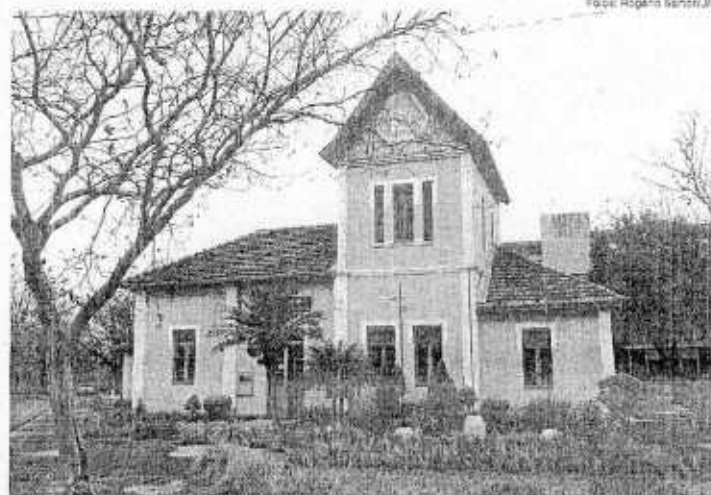
Memorial Coluna Prestes localiza-se no Prédio que era ocupado pela Estação Férrea
