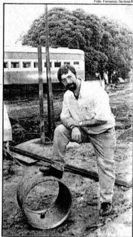
Maurício Bentes acompanha montagem do monumento
