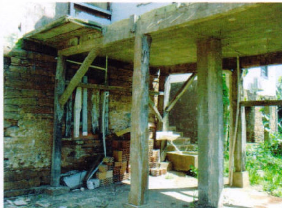
3 – Detalhe dos pilares de madeira e concreto que sustentavam o piso da cozinha.
