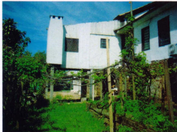
1 – Fundos do Salão Holler com anexo e cozinha demolida.
