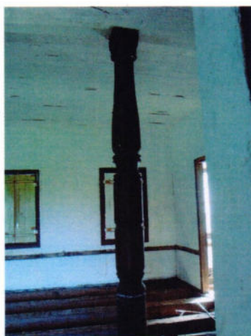
2 – Coluna torneada em madeira.
