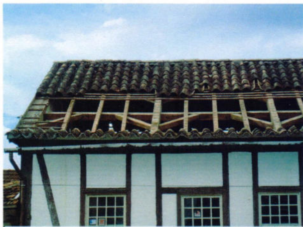
3 - Detalhe da remoção do telhado
