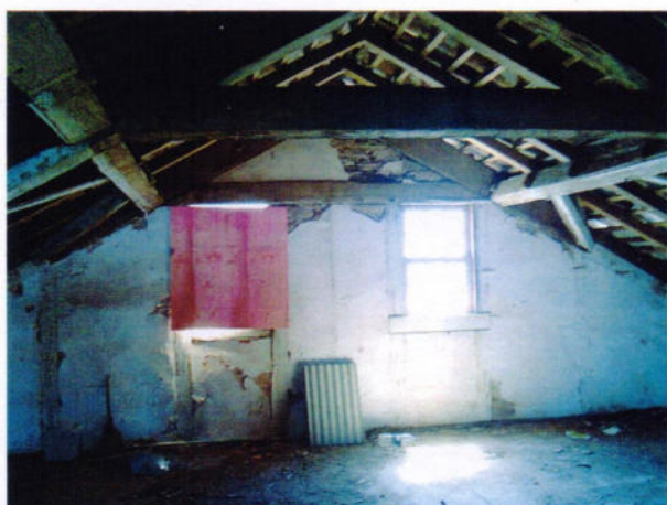
2 – Detalhe das janelas da ala norte do sótão. Uma foi removida e a outra, trocada.
