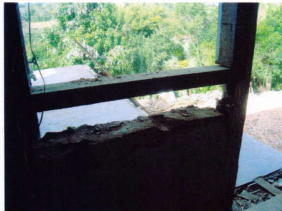
3 – Área de acesso à cozinha demolida.
