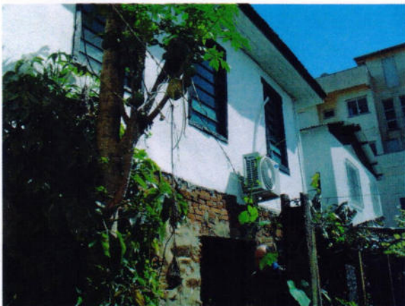
2 – Porão do Anexo ao salão.
