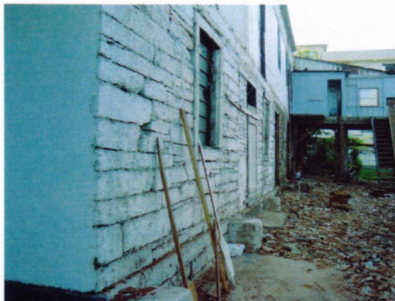
1 - Detalhe das pedras de arenito na parede do porão.
