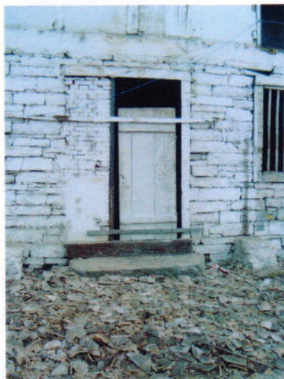
2 – Acesso ao porão, aos fundos do salão. Paredes em arenito.
