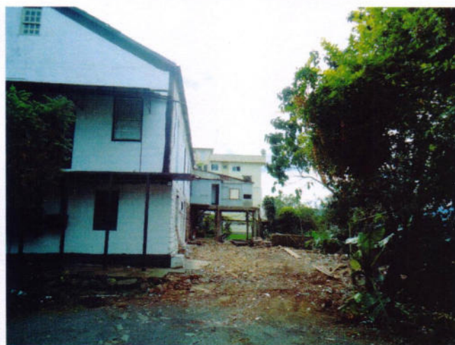
3 – Lateral Sul do Salão e área demolida.
