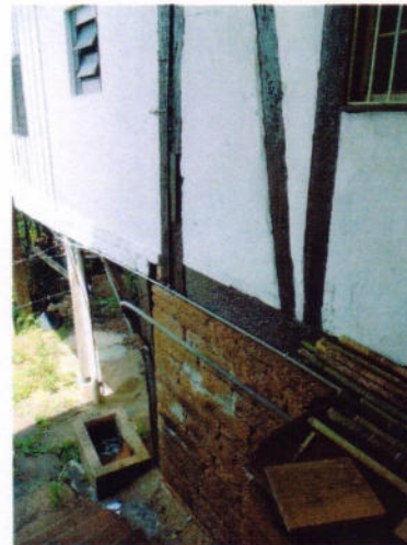
1 - Detalhe do enxaimel no térreo e pedras de arenito na parede do porão.
