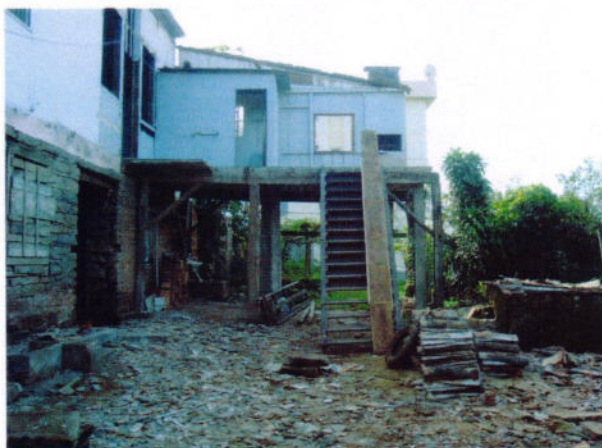
1 – Anexo em madeira e alvenaria (demolido).
