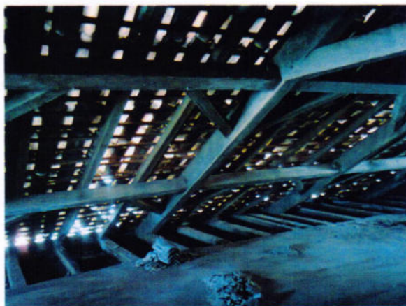
2 – Detalhe do telhado, com as telhas originais e o madeiramento original.
