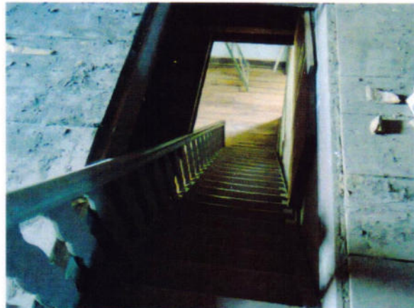
1 – Escada de acesso ao sótão.
