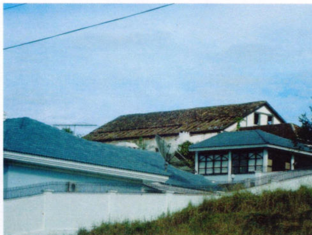
4 – Vista Leste (fundos) do telhado. Remoção das telhas.
