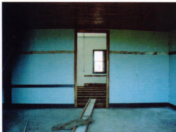
1 – Sala da entrada com acesso aos demais cômodos.
