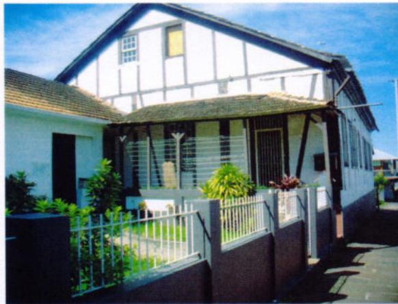
3 – Detalhe das Janelas pelo lado externo.
