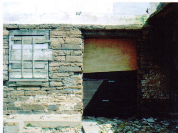
3 – Detalhe das paredes do porão em arenito.
