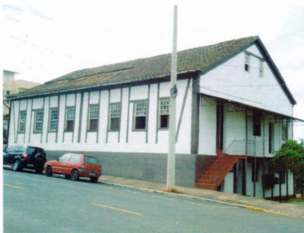
2 – Fachada principal, oeste. Detalhe da entrada lateral.
