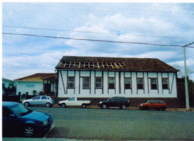
2 - Fachada Oeste (principal) com remoção de parte do telhado
