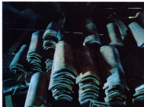
3 – Telhas originais removidas e depositadas no sótão.
