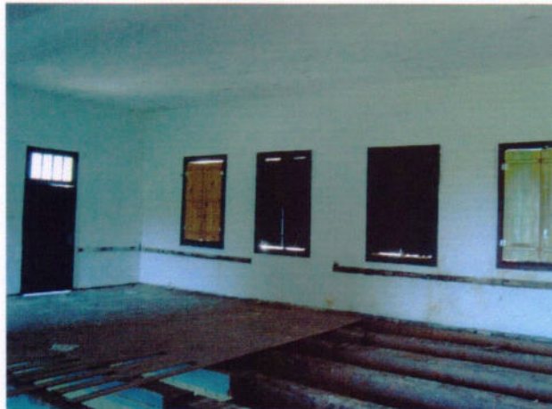
1 – Sala ala sul, com assoalho removido.
