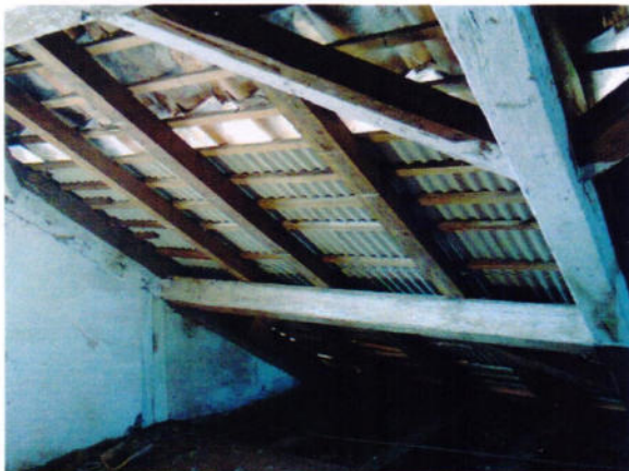
2 – Detalhe do telhado, onde parte das telhas originais foram removidas.
