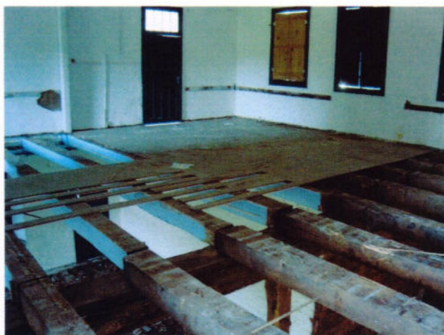
3 – Sala da ala sul. Assoalho removido.
