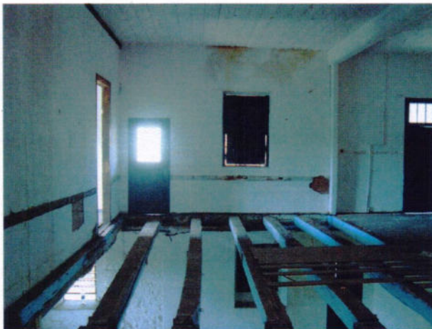
2 – Vigas de madeira do assoalho retirado.
