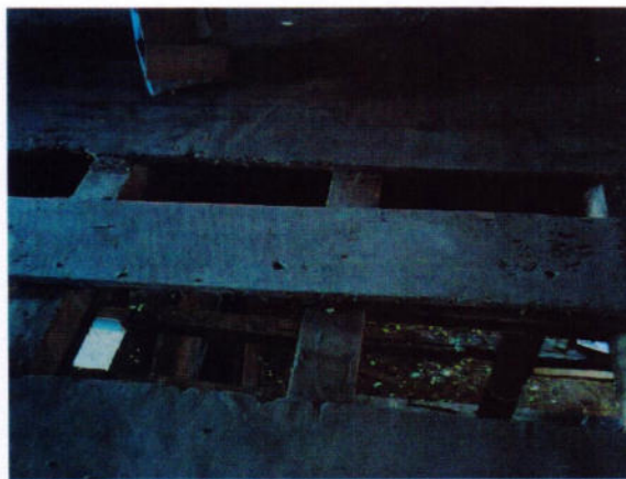
3 – Detalhe das aberturas no assoalho de madeira.
