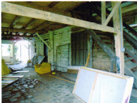
2 - Fundos do Salão com a cozinha ainda existente.
