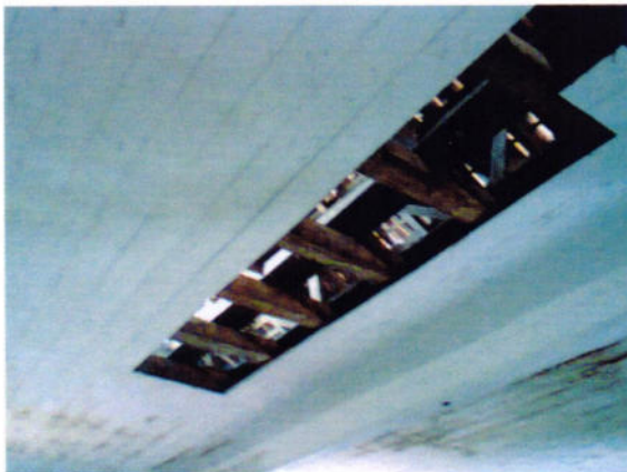
2 – Detalhe de parte do forro removido na sala sul.
