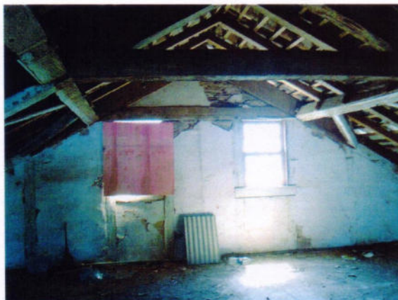
1 – Janelas da ala norte, modificadas.
