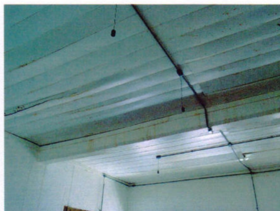
3 – Detalhe do forro em tábuas largas.
