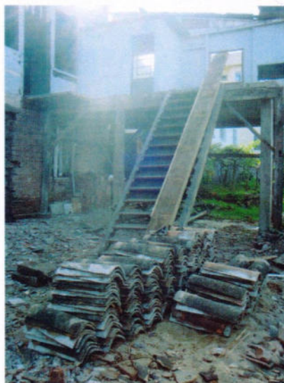
3 – Parte das telhas originais do salão.
