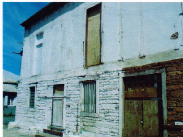
1 – Fundos do Salão Holler onde ficava a cozinha demolida.
