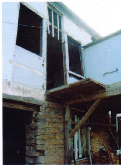
3 – Detalhes do acesso entre o salão e a cozinha (demolida).
