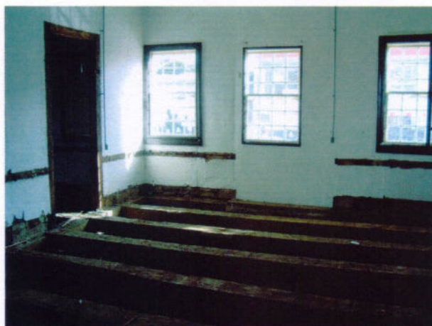
1 – Sala ala oeste, com assoalho removido.
