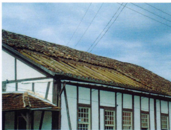
4 – detalhe do telhado onde houve remoção das telhas.
