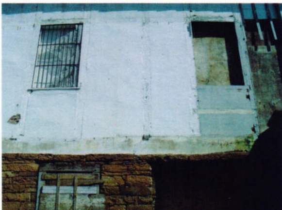
2 – Detalhe das paredes do térreo. Parede divisória entre o salão e a cozinha
