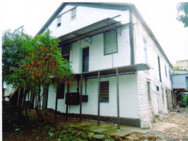
2 – Detalhes da varanda no pavimento térreo. Acréscimo posterior.
