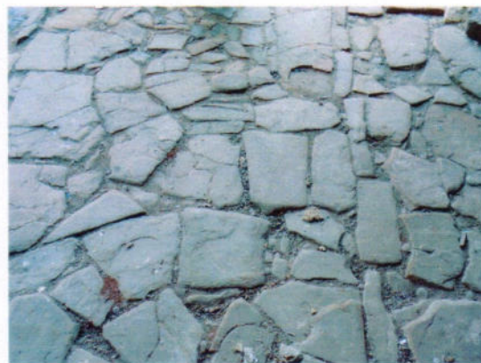
3 - Detalhe do piso em ardósia. No porão abaixo da cozinha
