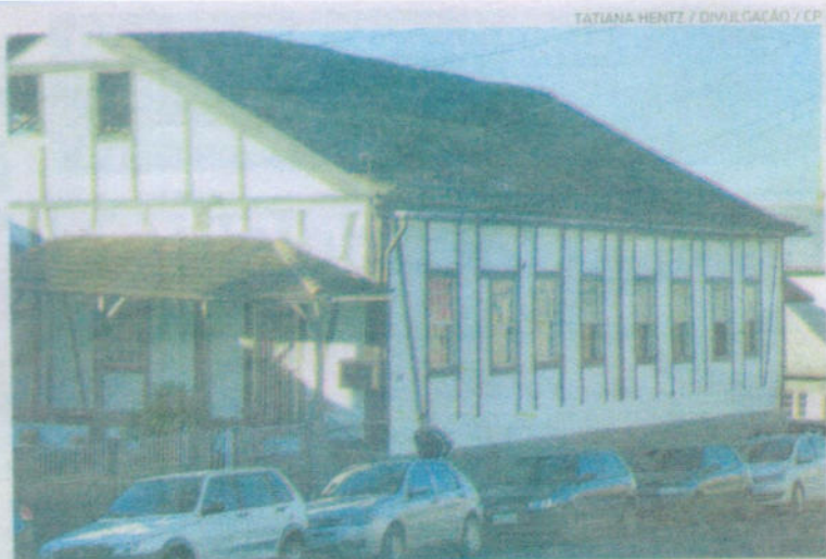
A construção é a maior no estilo enxaimel encontrada no Rio Grande do Sul
