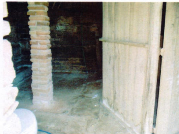
3 – Parte interna do porão do anexo.
