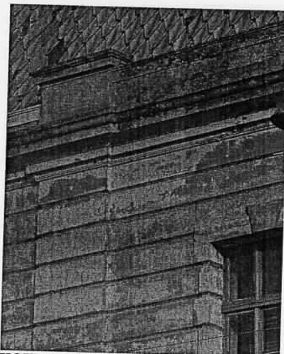
FIGURA 182: Detalhe da bossagem e pilastras
