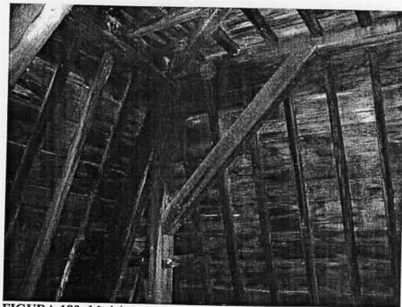
FIGURA 189: Madeiramento do telhado da cobertura
