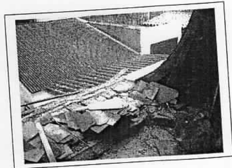
Foto das telhas de cerâmica de aproximadamente 4mm em detalhe - junho 2003
