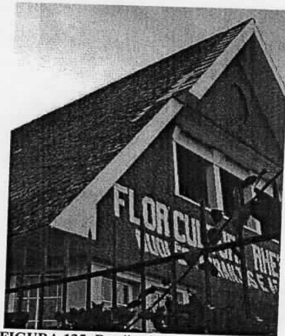
FIGURA 135: Detalhe da cobertura
