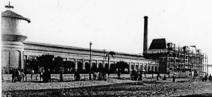
FIGURA 175: Foto da construção
