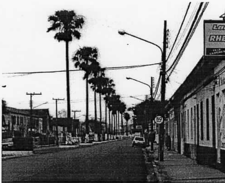
FIGURA 77: Vista das casas de operários
