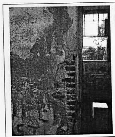
Revestimento das paredes e Técnica construtiva Foto: junho/2003
