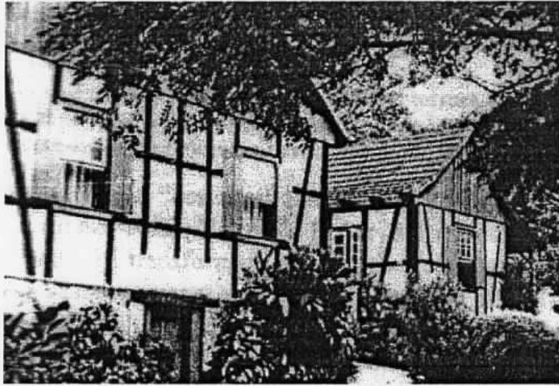
FIGURA 165: Construções feitas no Rio Grande do Sul
