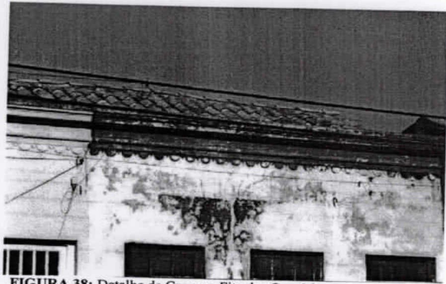
FIGURA 38: Detalhe de Casa em Fita dos Operários
