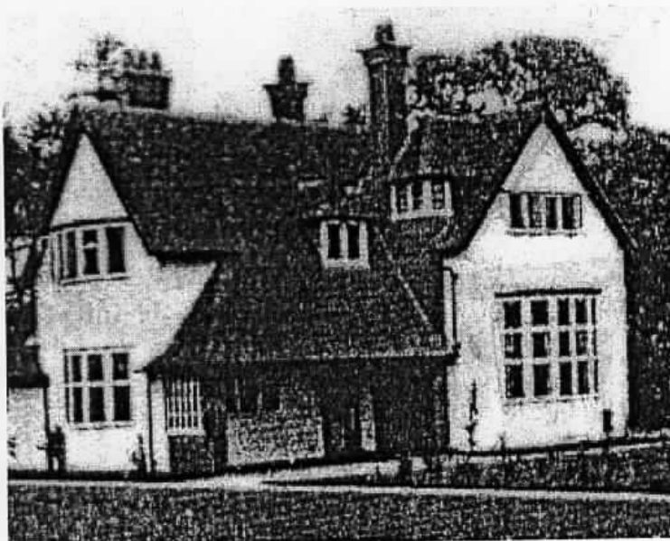
FIGURA 144: residência de Letchworth
