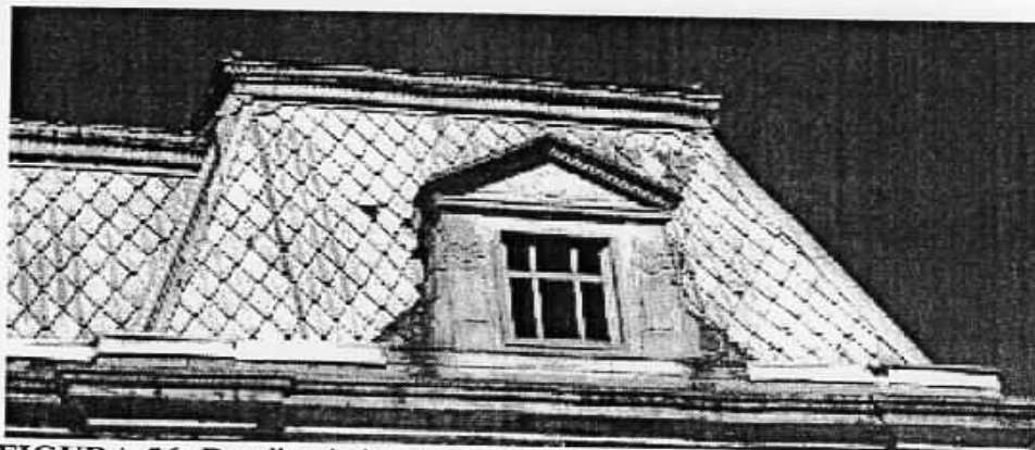
FIGURA 56: Detalhe da janela na cobertura
