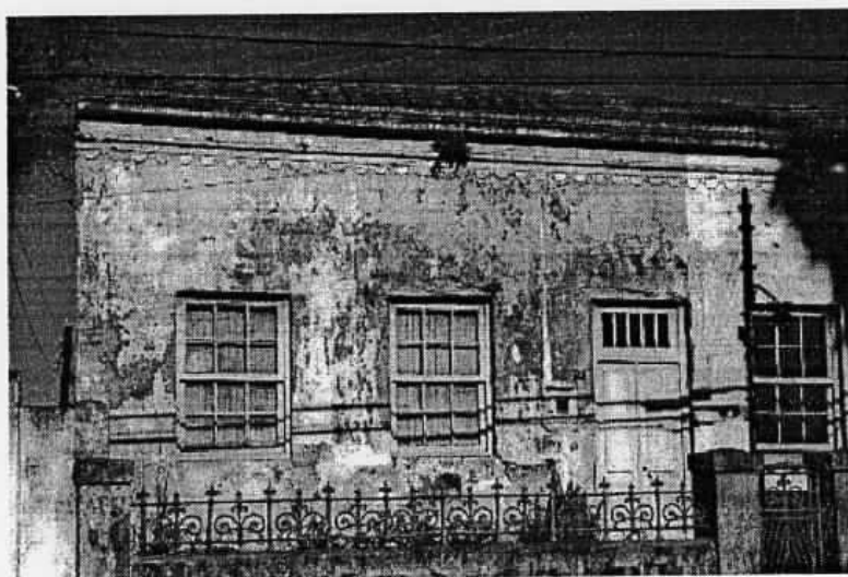
FIGURA 85: Casa de n. 131
