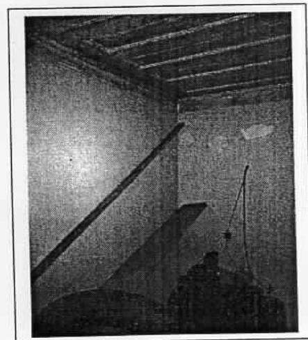
Detalhe forro saia-camisa Foto: junho/2003 local: sala frente do térreo
