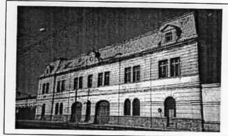
Fachada do Prédio Data: setembro/2002
