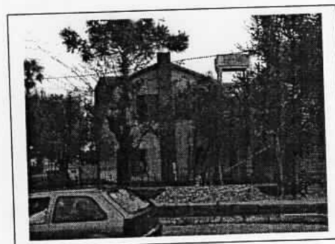
Detalhe da esquina onde está implantada a casa 4 Foto: outubro /2002
