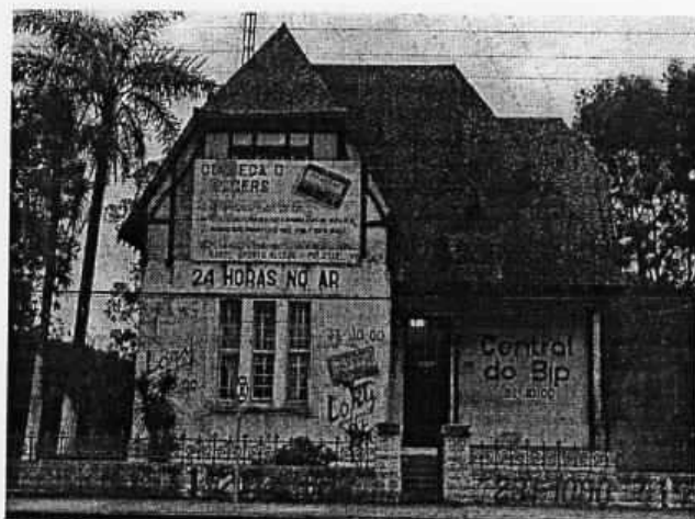
FIGURA 139: fachada da casa 176
