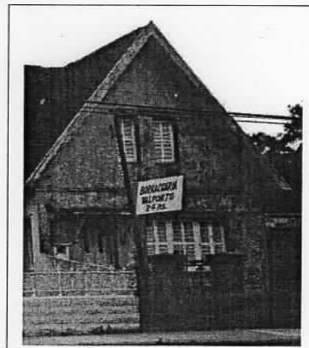
Porta de entrada Principal e fachada Foto:setembro/2002
