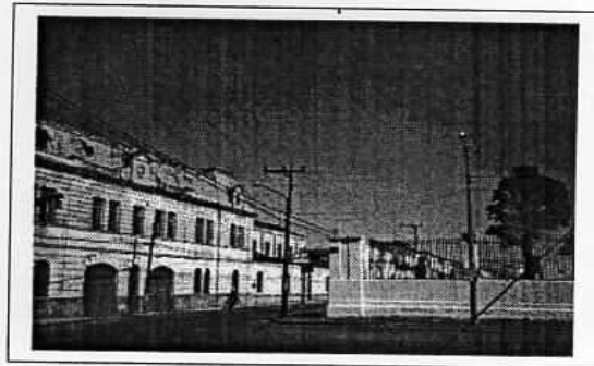
Foto mostrando o prédio e o cemitério à frente Data: setembro/2002
