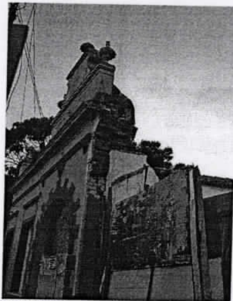
FIGURA 47: parte das casas demolidas.
