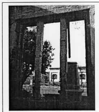
Marco da Janela tripla da que existia na fachada Foto:junho/2003
