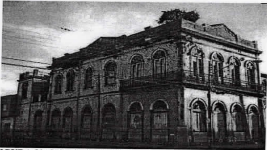
FIGURA 33: Sobrado dos Azulejos
