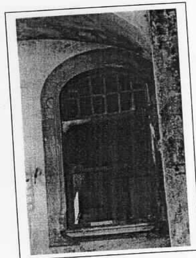
Detalhe de uma janela - presença de bandeira Foto: setembro/2002
