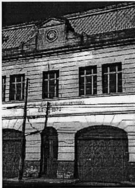
FIGURA 57: Detalhe das esquadrias da fachada
